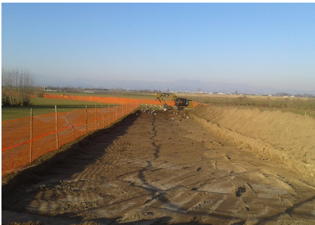
Fig. 2.3.2-A – Foto di apertura della pista di lavoro
