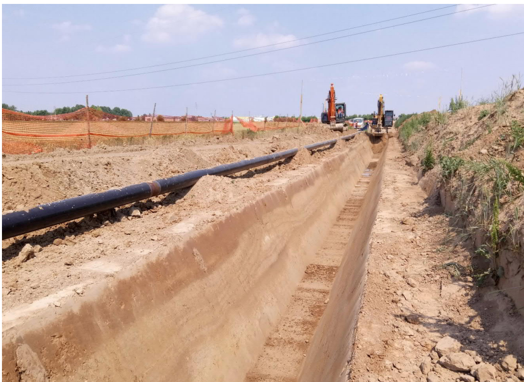
Fig. 2.3.3-A – Foto tipica di scavo della trincea
