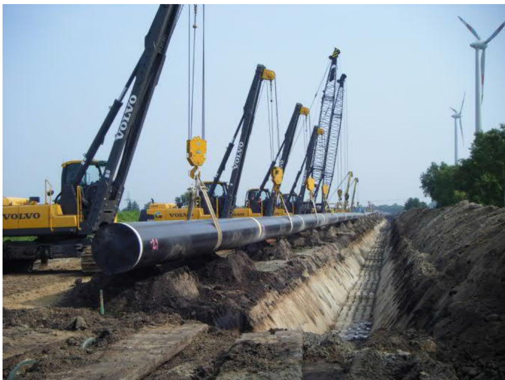
Fig. 2.3.4-A – Posa della condotta
